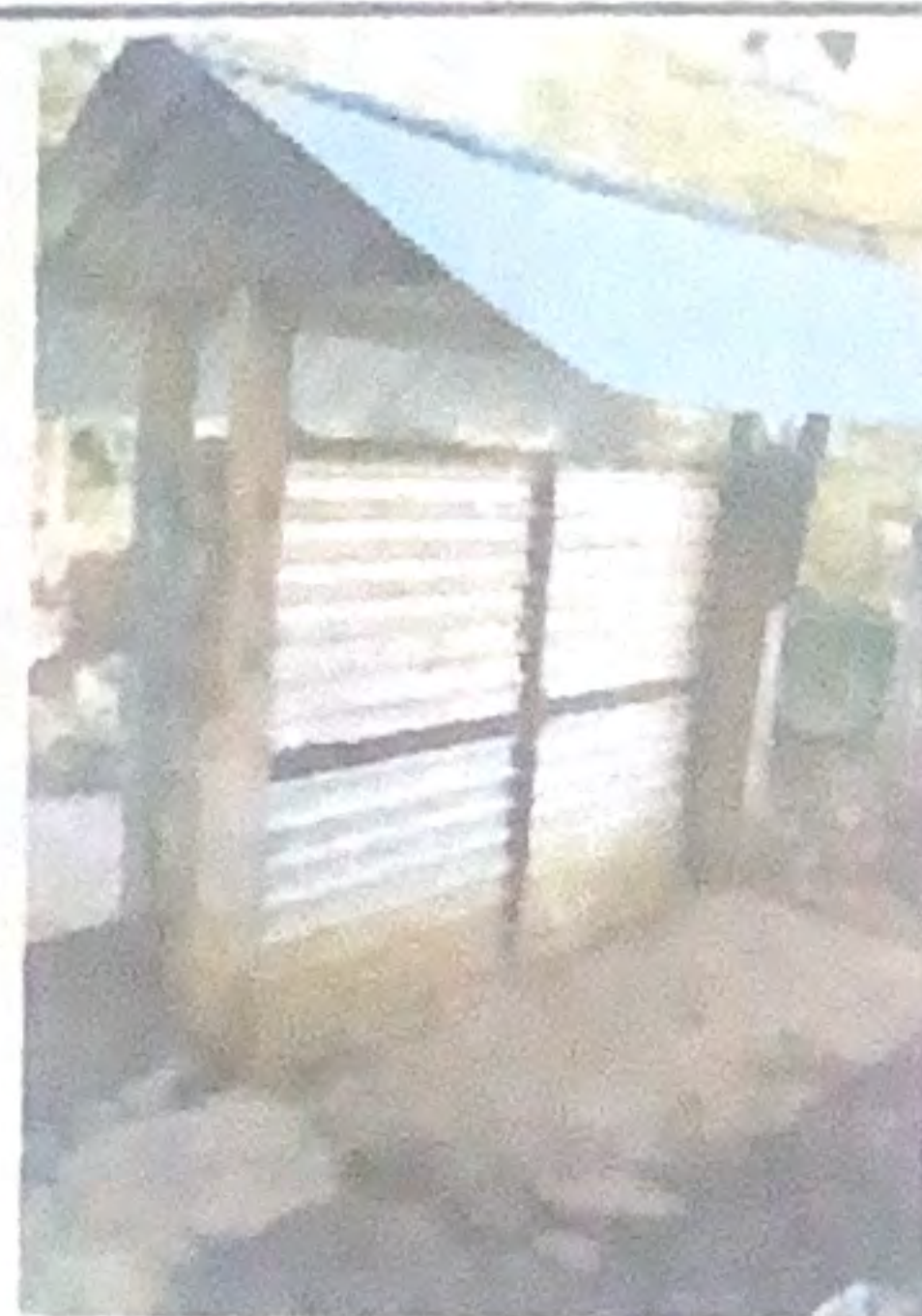
Cambio de puerta principal y entachado.
